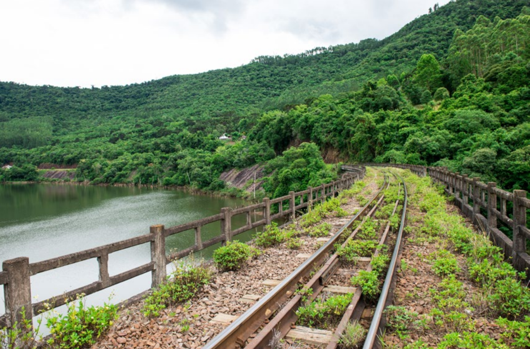
Ponte férrea sobre o rio Turvo. 16/12/2019. Autoria: Anthony Beux Tessari.
